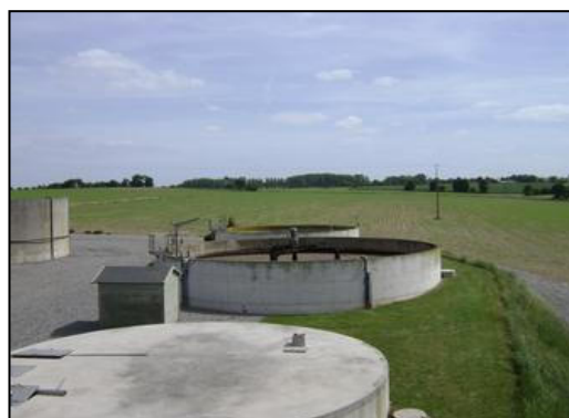
Installation de traitement
